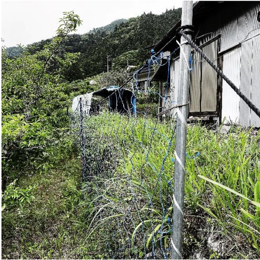
石垣の下に設置された防護柵
