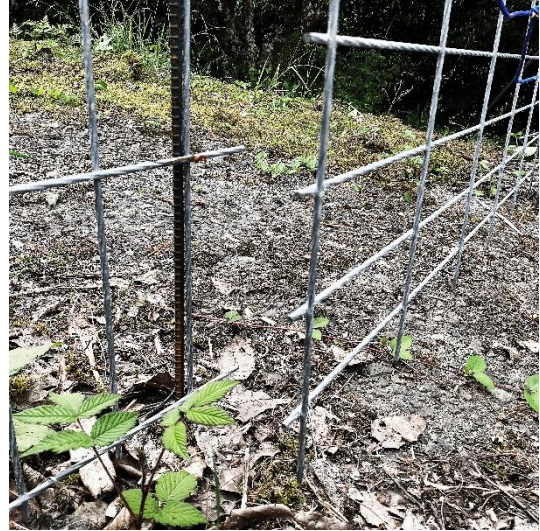
出入口下部の隙間
